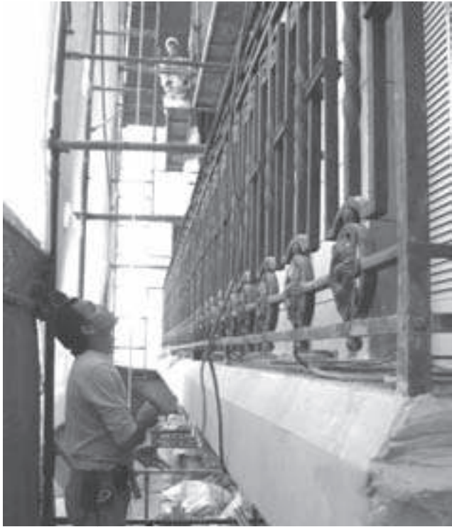
Marcelo Santa Cruz revisa los trabajos de restauración
