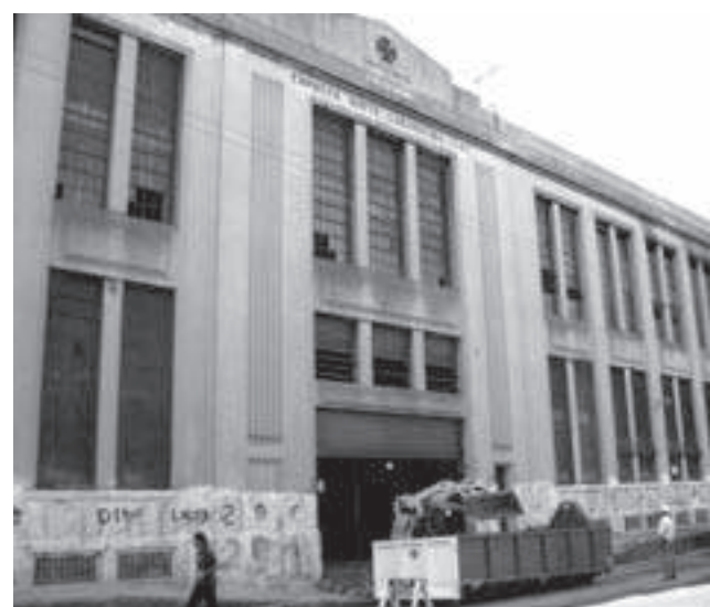
La antigua yerbatera Cruz de Malta en renovación
